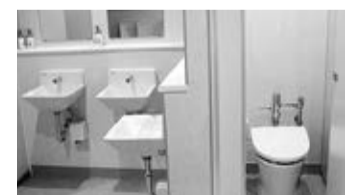
洋式化工事を行った学校トイレ
