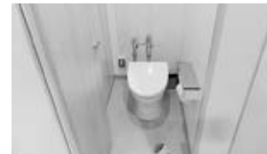
洋式化工事を行ったトイレ
