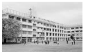
外壁の改修工事を行った校舎
