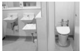
洋式化工事を行ったトイレ
