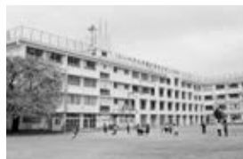
外壁の改修工事を行った校舎
