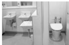
洋式化工事を行ったトイレ
