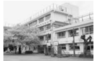
外壁改修を行った第二小学校
