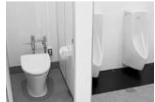
洋式化工事を行った学校トイレ
