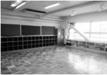
床改修を行った第七小学校教室
