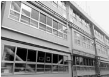
外壁改修を行った第七小学校
