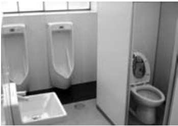
洋式化工事を行った学校トイレ
