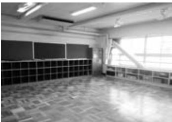
床改修を行った第七小学校教室
