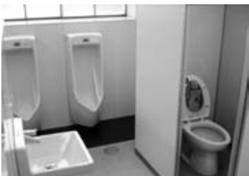
洋式化工事を行った学校トイレ
