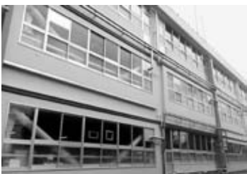
外壁改修を行った第七小学校
