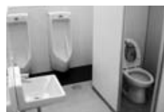
整備後の学校トイレ (第一中学校)
