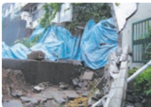
井の頭地区の土砂崩れ
