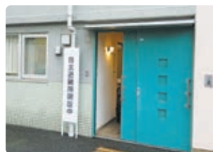
市営大沢住宅集会所の自主避難所
