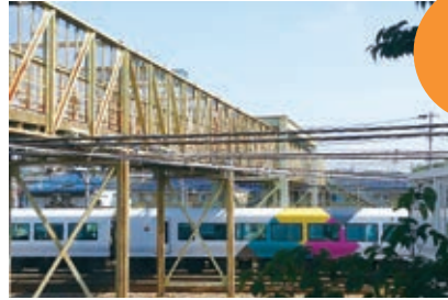
正式名称は三鷹電車庫跨線橋
