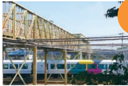
正式名称は三鷹電車庫跨線橋
