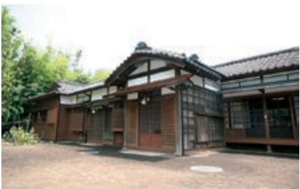
復元・再築された同施設
