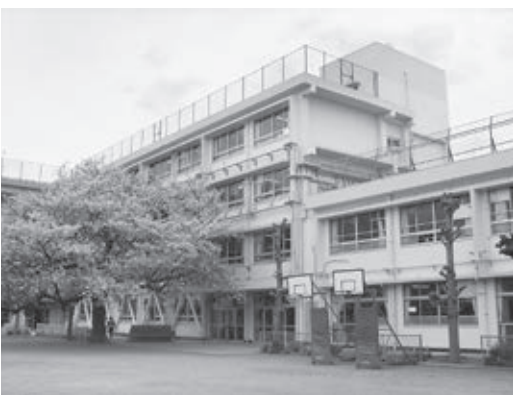
長寿命化改修工事後の第二小学校
