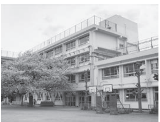
長寿命化改修工事後の第二小学校
