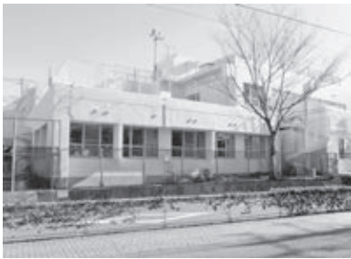
外装の工事を終えた東多世代交流センター
