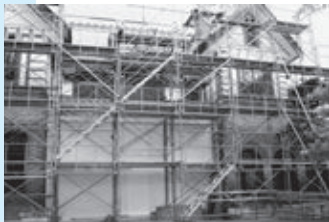
改修工事中の山本有三記念館
