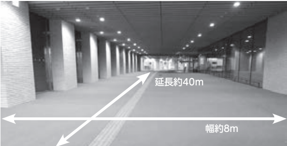
写真①東広場側入り口からエントランス方向
