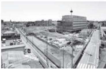
三鷹中央防災公園・元気創造プラザの工事状況(5月時点)
