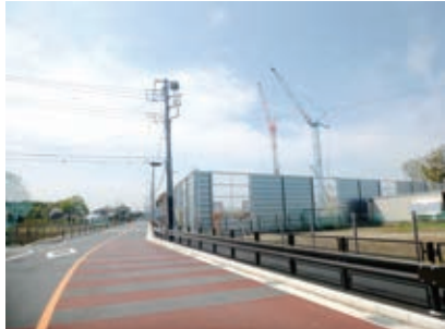
東京外かく環状道路の工事風景
