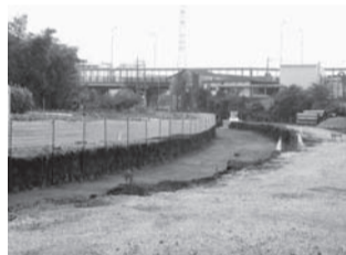
整備中の付け替え道路(北野中央通りから撮影)
