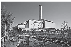
クリーンプラザふじみ
