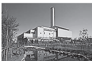
クリーンプラザふじみ
