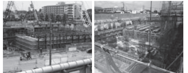
工事現場の様子
