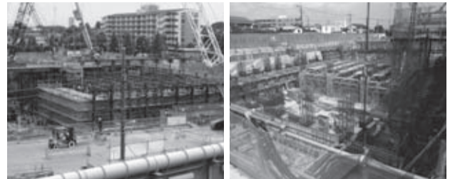
工事現場の様子
