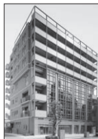
三鷹市下連雀市民住宅(外観)
