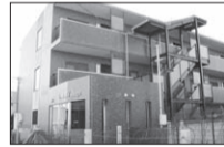
セントラルビレッジ(外観)
