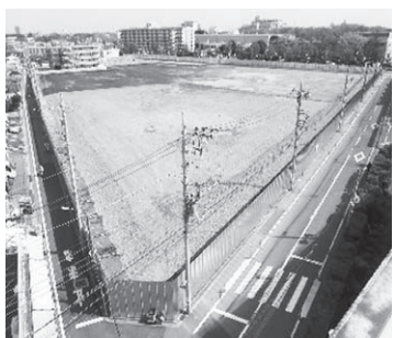
着工前の工事現場
