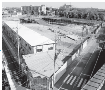
4月15日現在の工事現場
