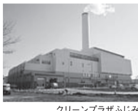
クリーンプラザふじみ
