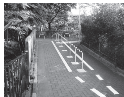
傾斜地に設置された「手すり」
