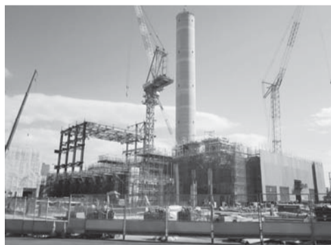
建設中の新ごみ処理施設(10月26日現在)
