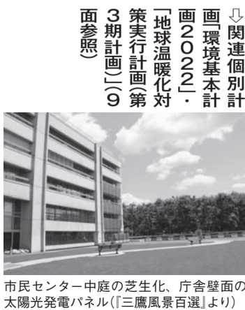
市民センター中庭の芝生化、庁舎壁面の太陽光発電パネル(「三鷹風景百選」より)
