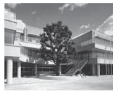
建て替え後の東台小学校
