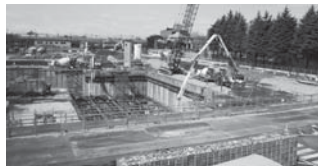
建設中の新ごみ処理施設
