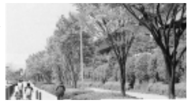
外環(埼玉区間)における環境施設帯の整備事例 対応の方針(素案)より
