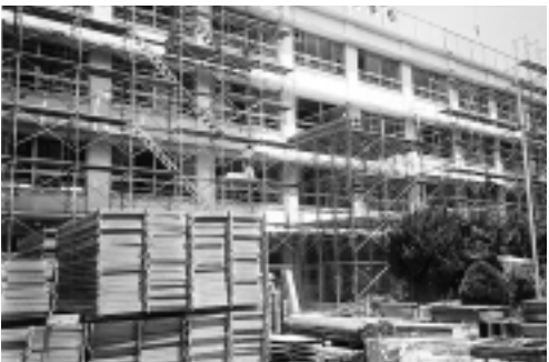
学校の耐震補強工事
