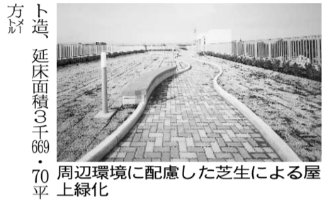
周辺環境に配慮した芝生による屋上緑化
