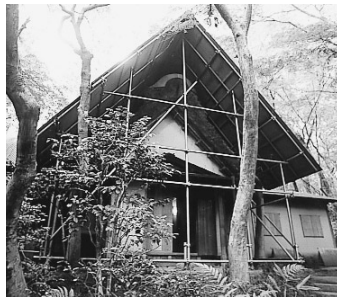
トタン屋根で覆われた「高風居」
