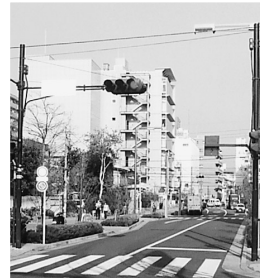
平成6年度から工事を行ってきた、三鷹駅前東西道路の結ぶ道路工事(区域内幹線道路整備事業)が完了し、4月1日に全面開通しました。今回完成した道路は、幅員が約11.522mで、両側に約2.8mの歩道を設けています。
