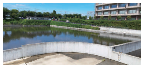
令和6年大雨時の貯留状況
