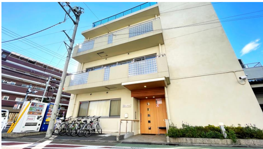
ひまわり第一の建物 (連雀通り沿い)
