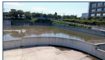
令和6年大雨時の貯留状況
