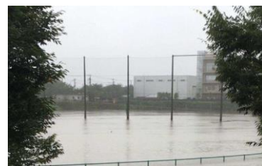
野川大沢調節池 〈令和元(2019)年台風19号による状況〉
