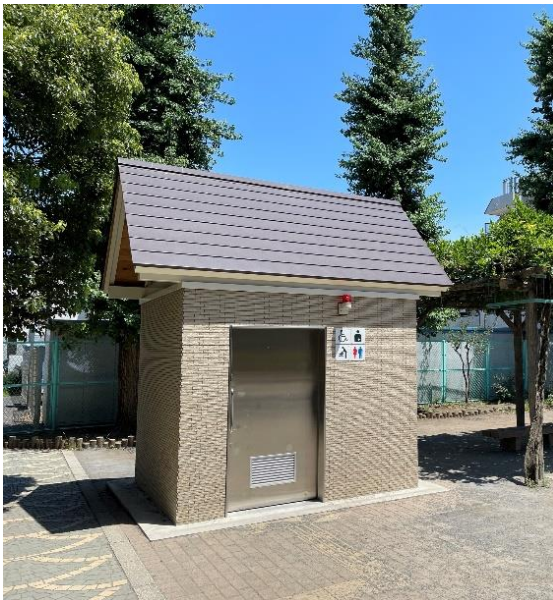
公園トイレの整備
