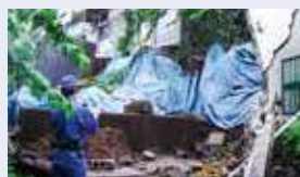
山体滑坡 (井之头地区)
