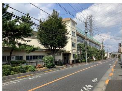
東側道路 1（都道 114 号線）
