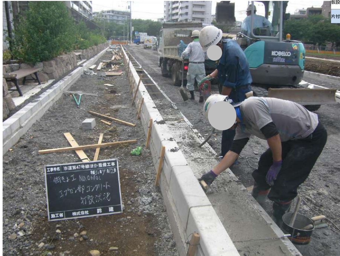
※写真は街渠築造工のイメージ
