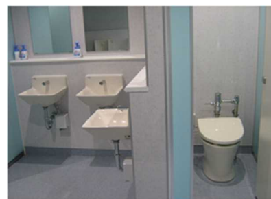
▲改修後のトイレ(井口小学校)
