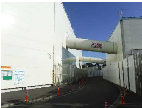
ベルトコンベアの状況 (令和6年11月29日)
