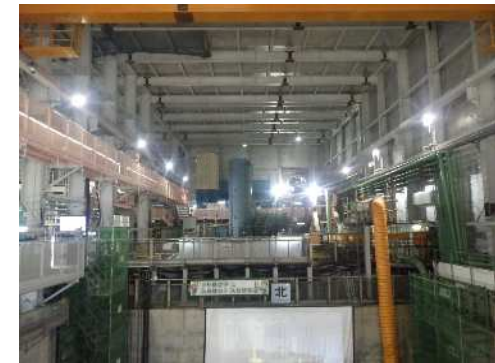
防音ハウス内の状況 (令和6年11月29日)
