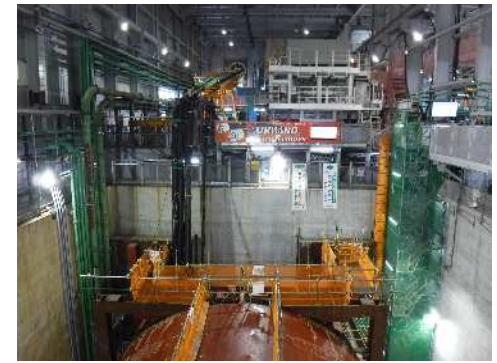
防音ハウス内の状況 (令和6年11月29日)
