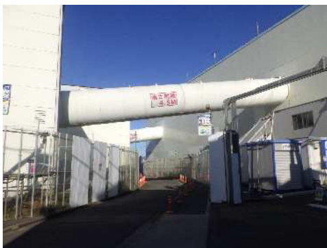
ベルトコンベアの状況 (令和6年11月29日)
