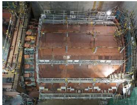
発進立坑部の状況 (令和6年11月25日)
