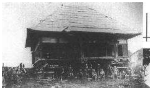
＜現在地へ移転する長久寺本堂の曳家の様子＞
