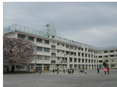
▲長寿命化改修後の第二小学校
