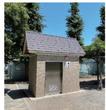
公園トイレの整備
